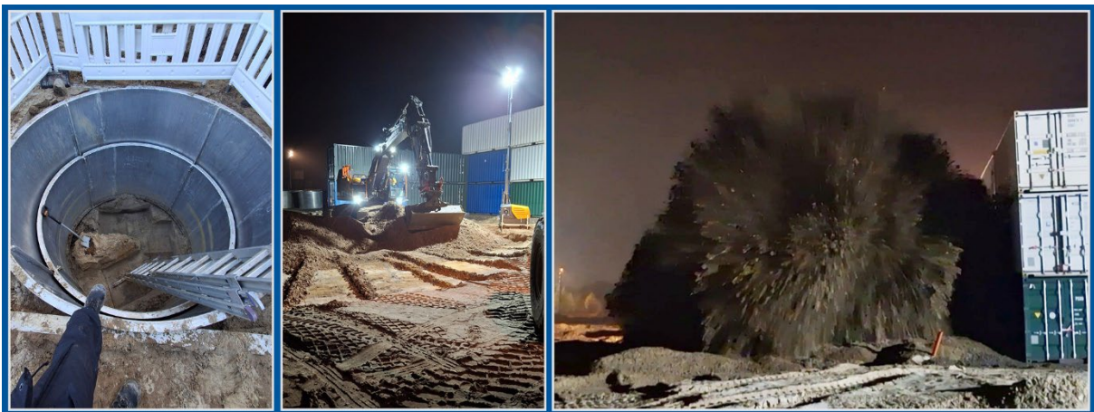
Abbildung 9: freigelegte Munition, Abdeckung vor Sprengung und Sprengung
