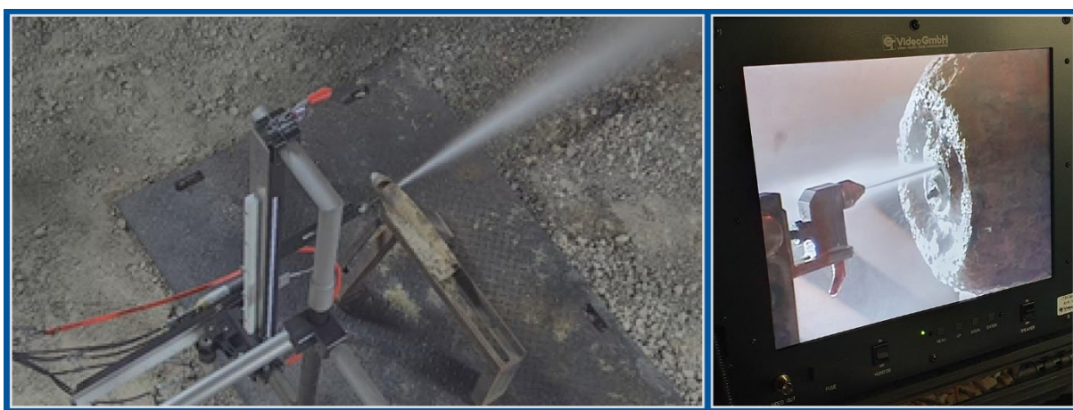
Abbildung 3: Wasserstrahlschneidanlage bei Übung und im Einsatz (Fotos: KBD)
