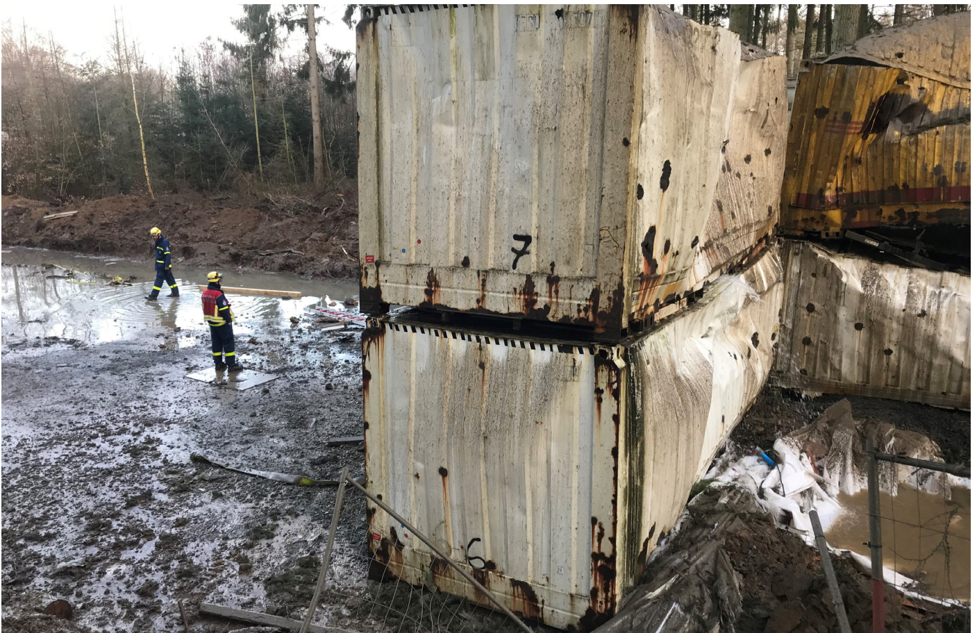
Auswirkung nach der Sprengung
