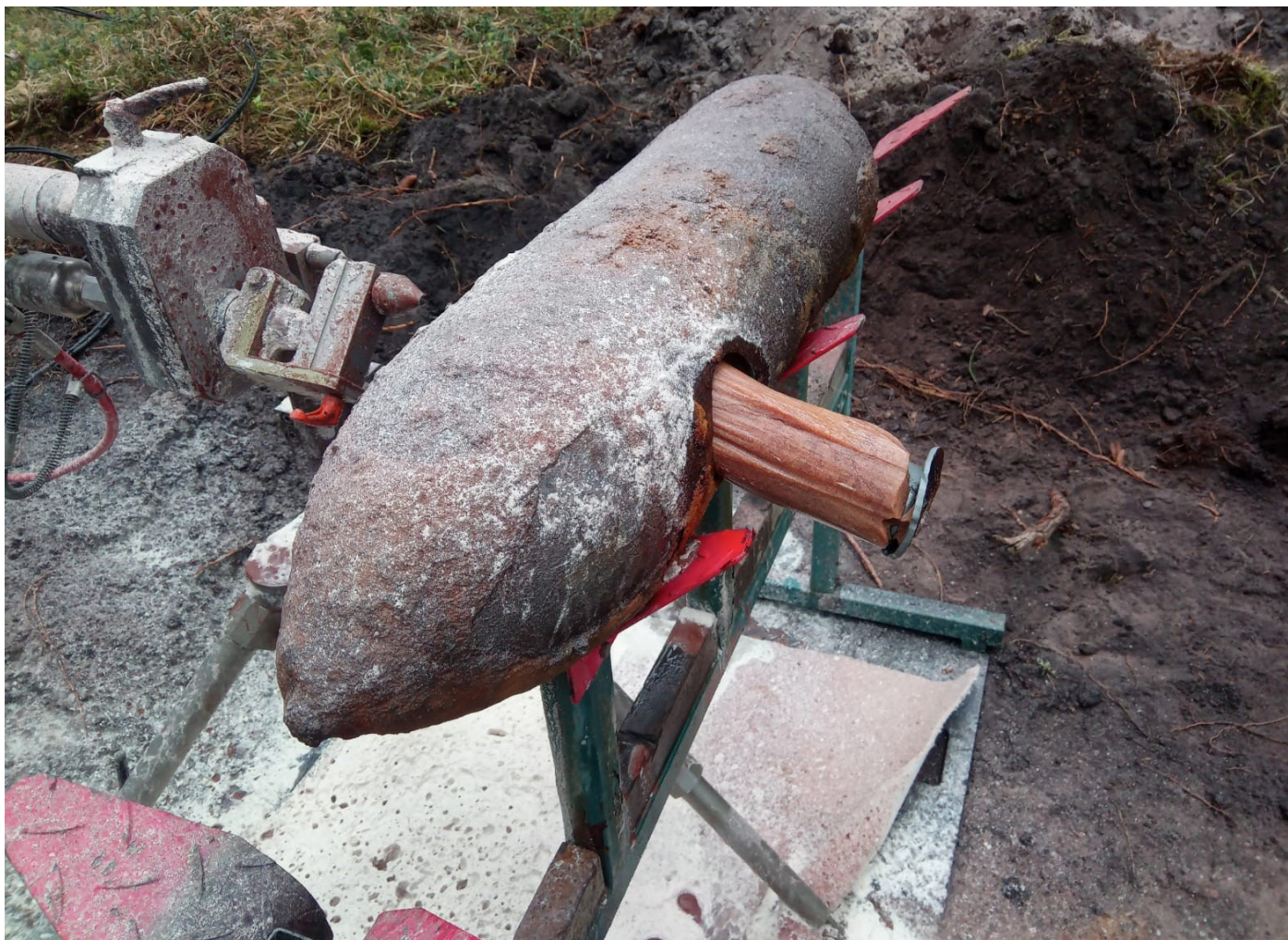
Zünder wurde freigeschnitten und kann entfernt werden
