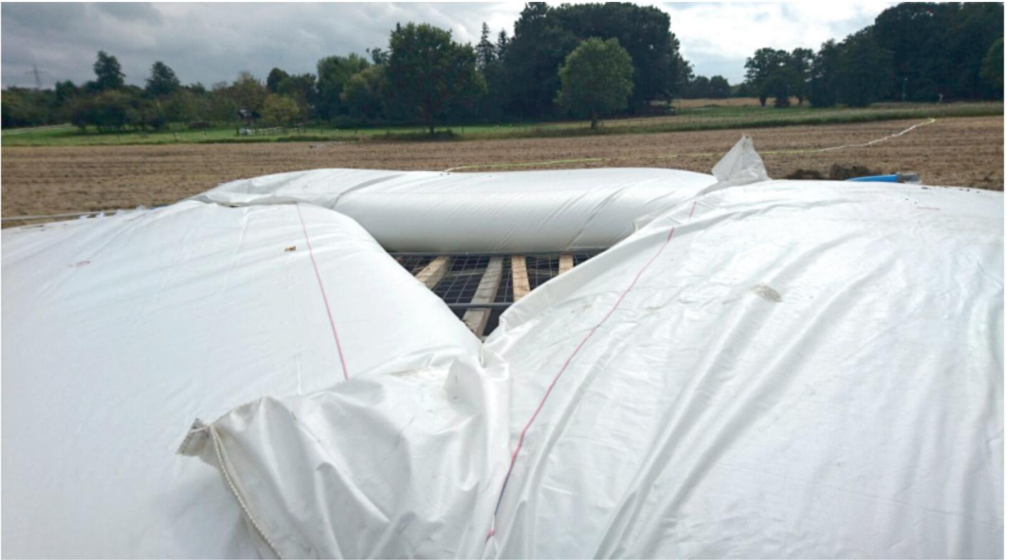
Abb. 3.1: Mit Wasserkissen und Druckentlastungsöffnung vorbereitete Sprengstelle
