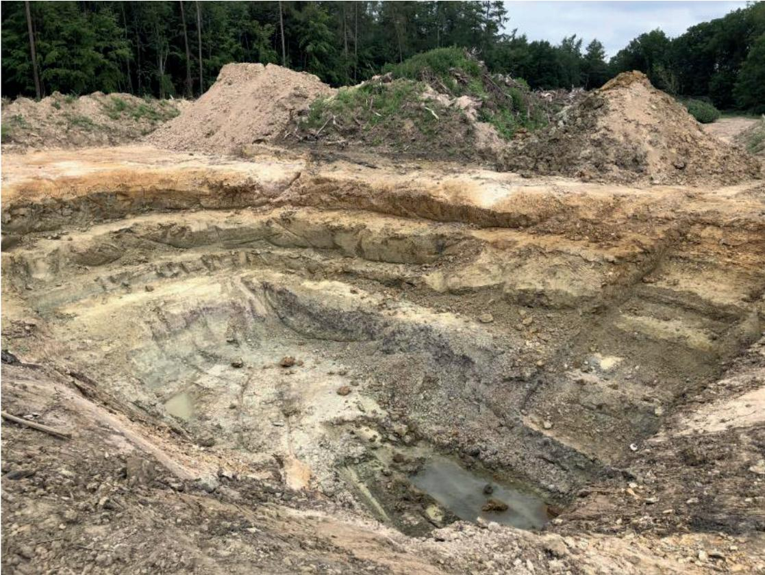
Abb. 10: Trichterräumung auf der Räumstelle der ehem. Munitionsanstalt Lenglern
