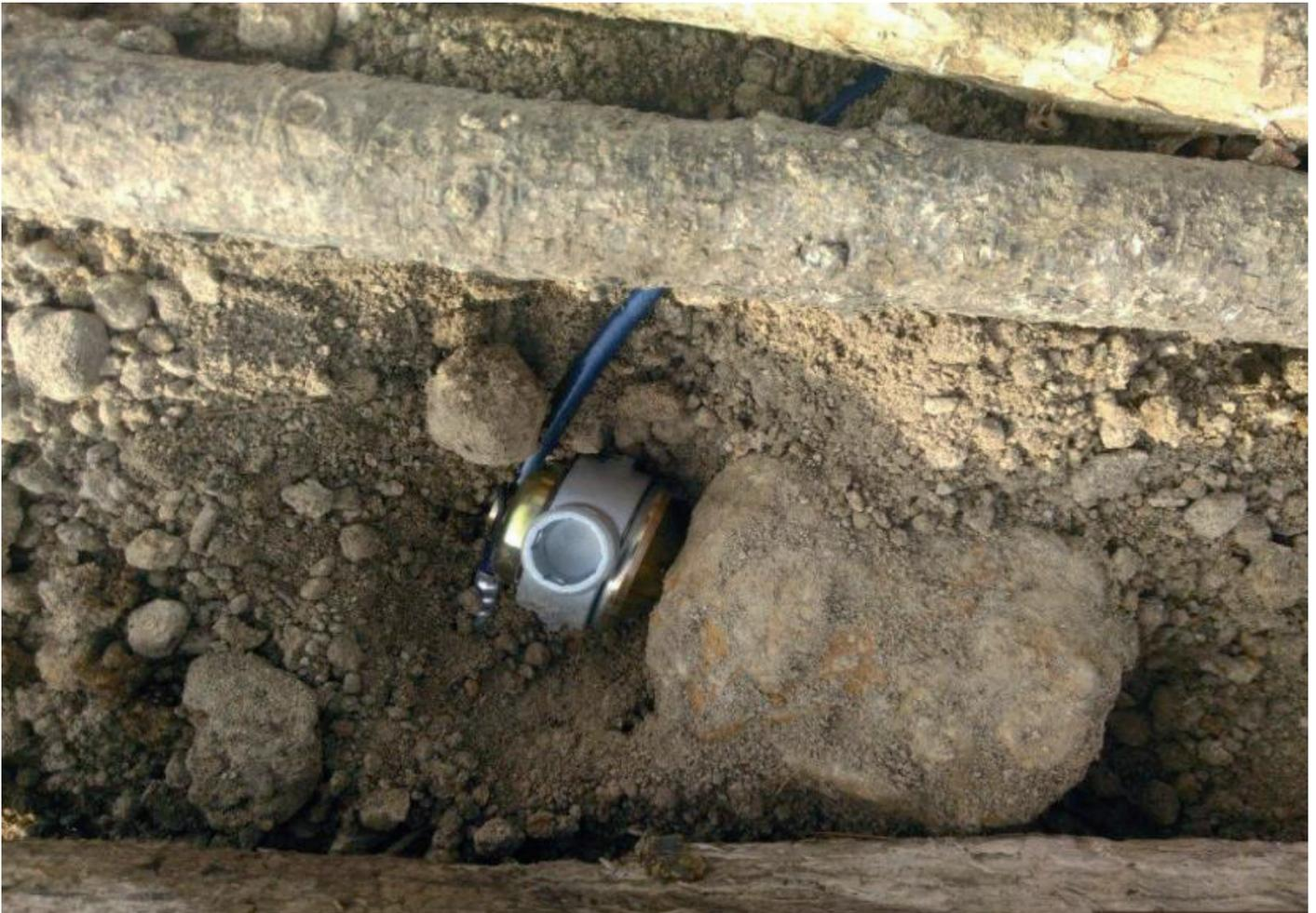
Abb. 1: Anbringung einer Sprengladung an einem nicht transportfähigem Kampfmittel (SD 2)
